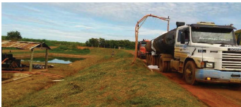
Figura 188 – Lagoas de Chorume no Aterro municipal – Detalhe da coleta do chorume que será destinado para a ETE Franca.
