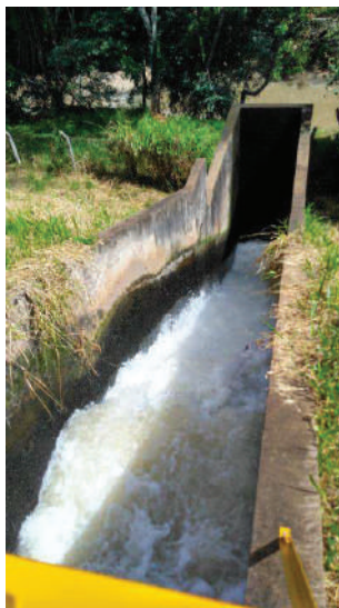
Figura 131 - ETE Franca - Escada de aeração e lançamento no Córrego dos Bagres.
