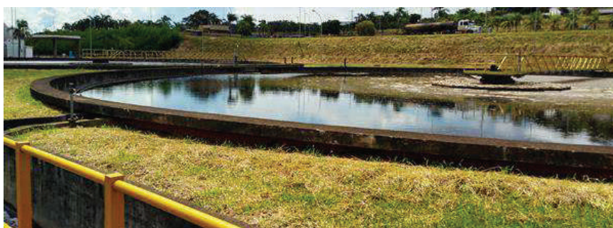
Figura 123 - ETE Franca – Setor 4 - Decantadores Secundários 1 e 2 - visão geral.
