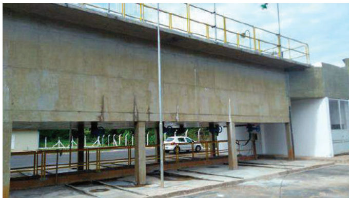
Figura 96 - Captação do rio Sapucaí-Mirim - Caixa de areia e descarte de areia de fundo.
