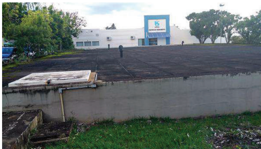
Figura 55 - Reservatório Enterrado RN1.
