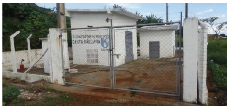
Figura 146 - EEE Santa Bárbara I - Vista geral.
