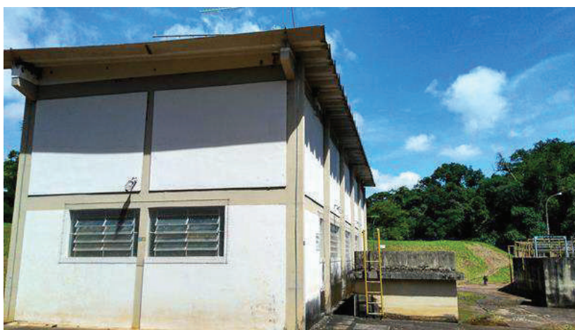
Figura 38 - EPA1 - Vista geral da casa de bombas.
