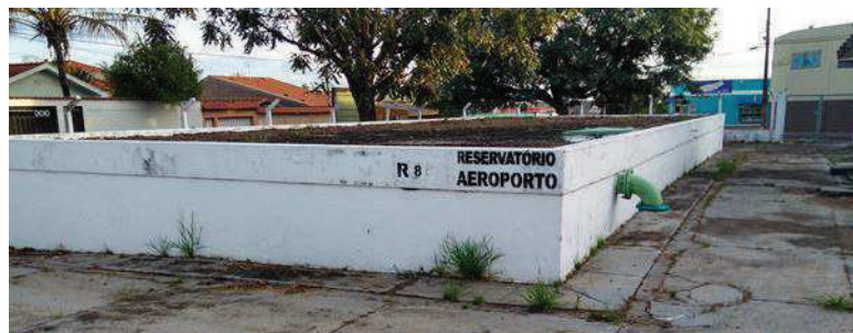
Figura 81 - Sistema Aeroporto (SA) (Setor VIII) - R8 com Booster para a zona alta do bairro Aeroporto.
