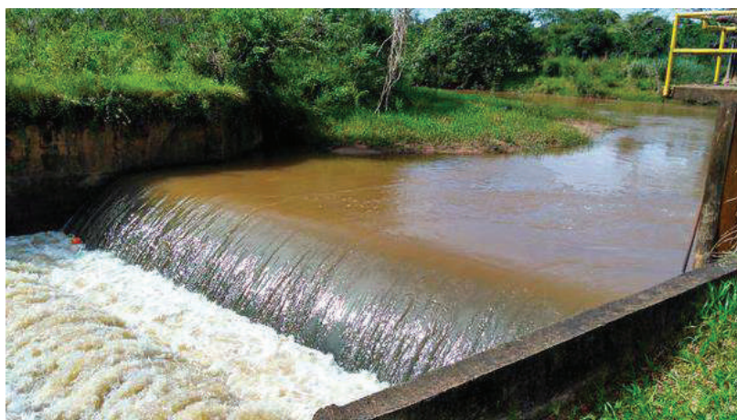
Figura 33 - EC1 - Barragem de elevação de nível de água do Rio Canoas.
