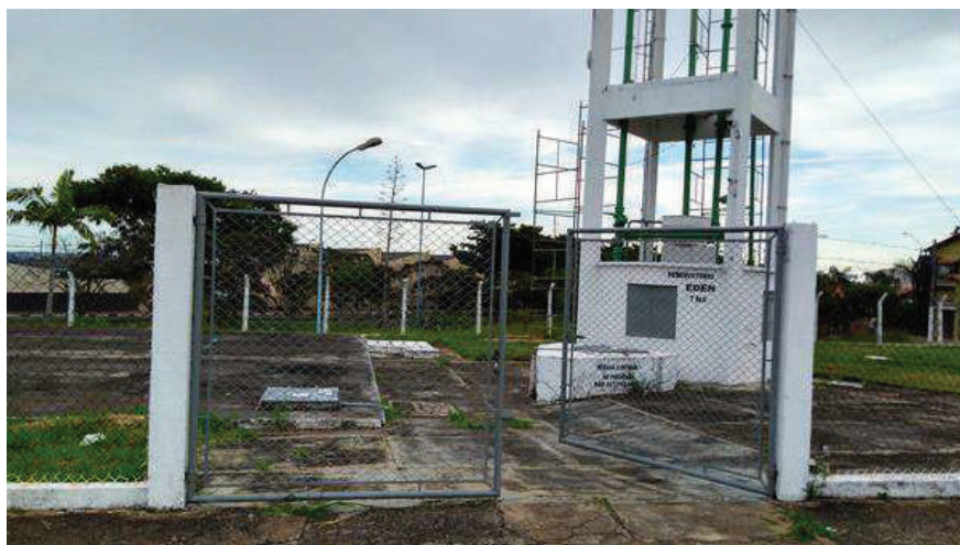
Figura 76 - Sistema Éden (Setor VI) – Reservatórios - Vista geral.
