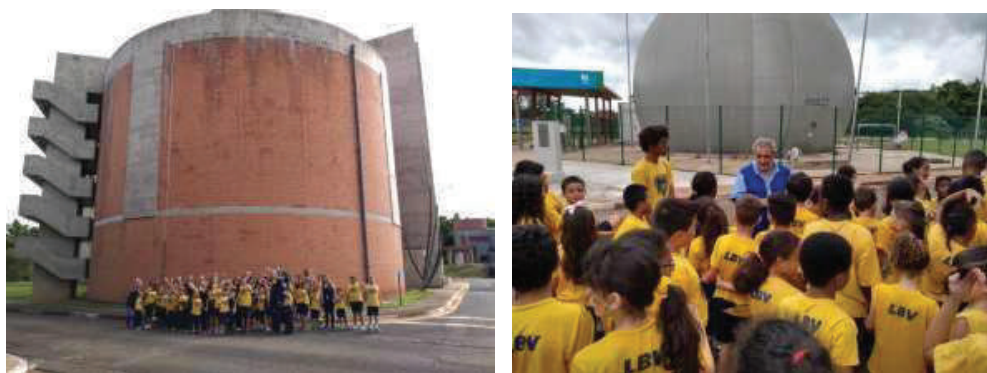
Figura 22 - Visita à Estação de Tratamento de Esgoto - Creche Escola da Legião da Boa Vontade - 22.03.2019
