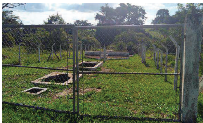
Figura 173 - ETE Fossa Filtro Morada Verde - Vista geral.
