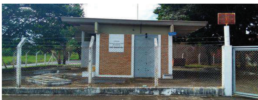
Figura 114 - EEE São Sebastião - Vista geral.
