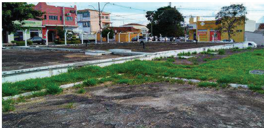
Figura 73 - Sistema Santa Cruz (SSC) (Setor V) - Reservatórios Santa Cruz - RN5.
