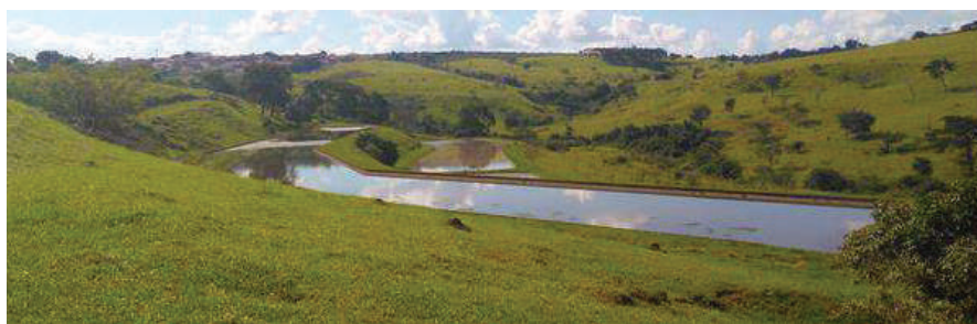
Figura 149 - ETE Aeroporto - Vista geral.
