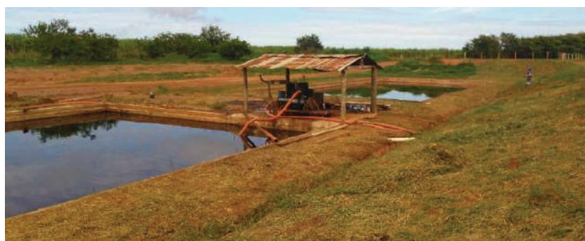
Figura 187 – Lagoas de Chorume no Aterro municipal.
