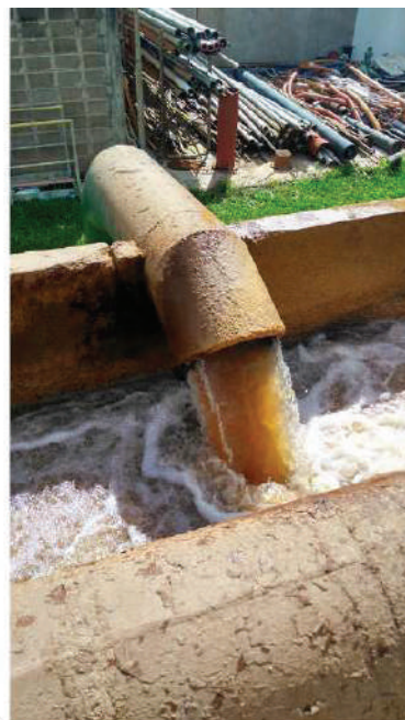
Figura 48 - ETA - Caixa de chegada de Água Bruta – Detalhes da chegada da captação Canoas (a) e chegada da captação Pouso Alegre (b).
