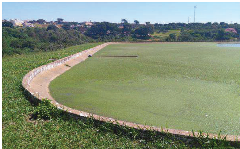
Figura 158 - ETE Palestina - 1ª lagoa facultativa (em paralelo com a 2ª lagoa facultativa) - detalhe para entrada de esgoto.
