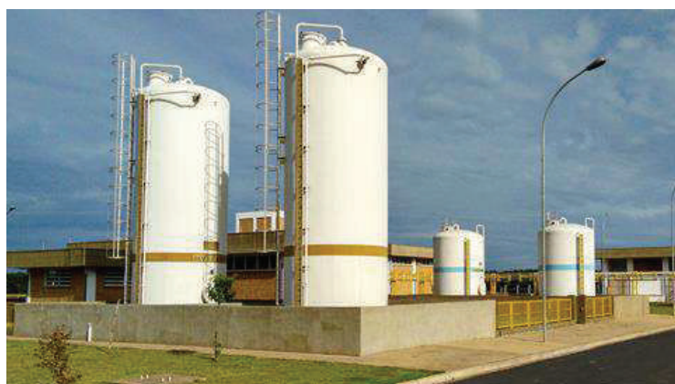
Figura 100 - ETA - Sistema de produtos químicos líquidos.
