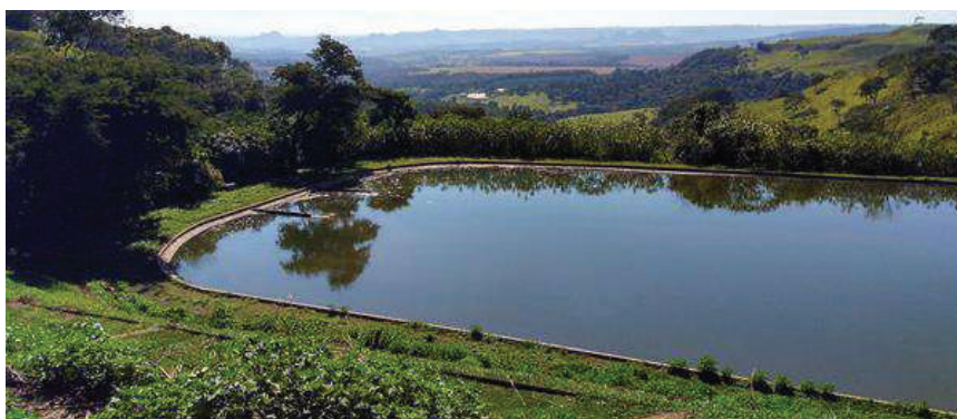
Figura 167 - ETE Paulistano II - Vista geral da 2ª lagoa facultativa (em série com a 1ª lagoa facultativa).
