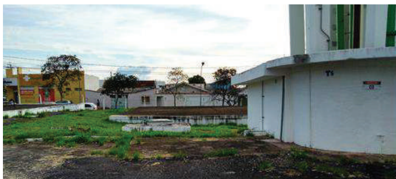
Figura 72 - Sistema Santa Cruz (SSC) (Setor V) - Reservatórios Santa Cruz - R5.
