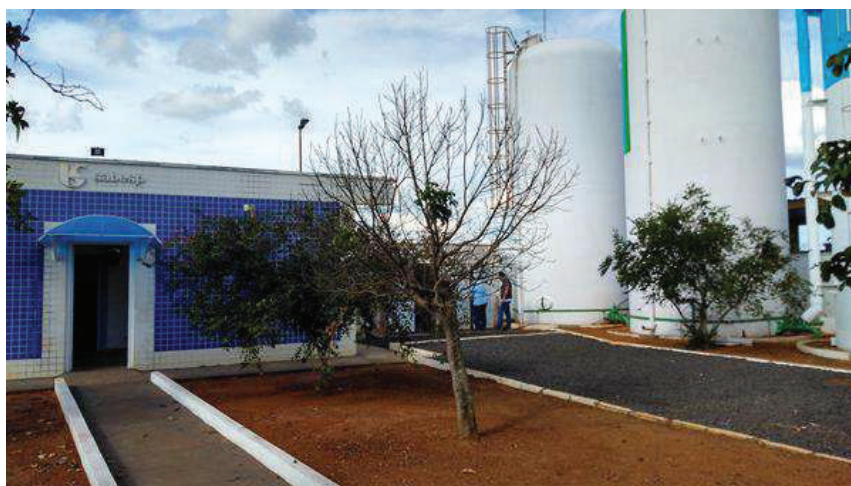
Figura 45 - Sistema Restinga - Centro de Reservação e Distribuição de Restinga - Vista geral.
