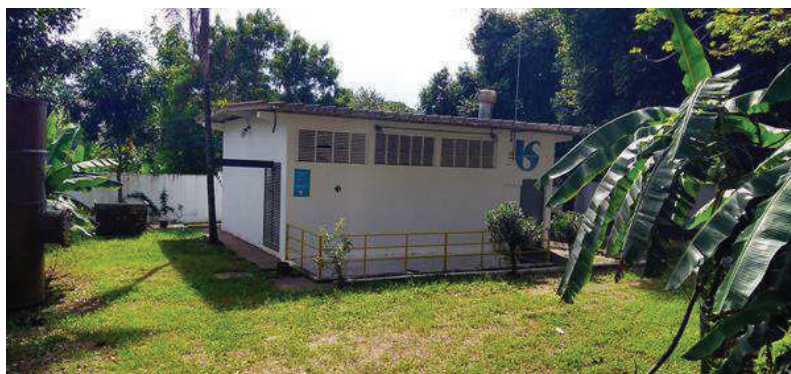
Figura 111 - EEE Leporace - Vista geral.
