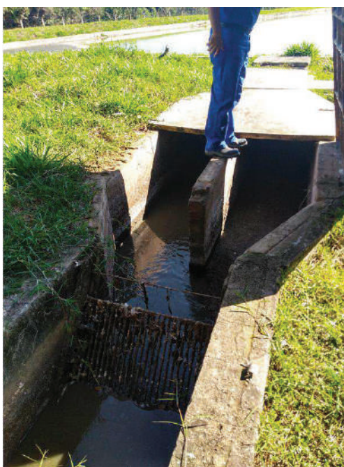
Figura 169 - ETE City Petrópolis – Gradeamento e caixa de areia.
