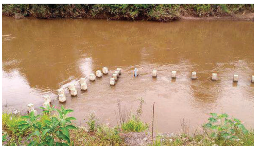
Figura 95 - Captação do rio Sapucaí-Mirim - Estrutura de captação com blocos de segurança, intanks e régua de nível.
