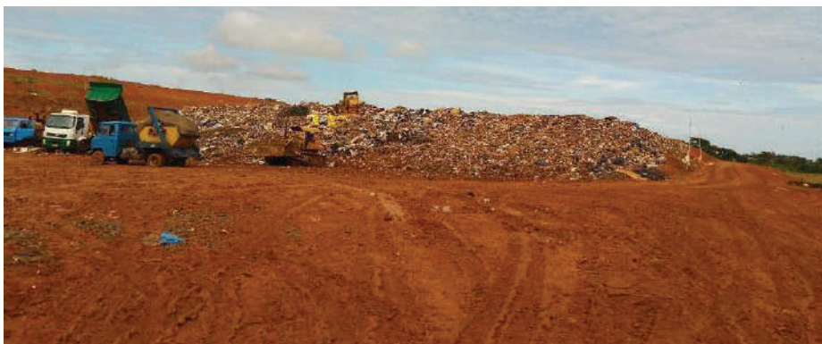
Figura 183 – Local de orientação e disposição final no Aterro municipal.
