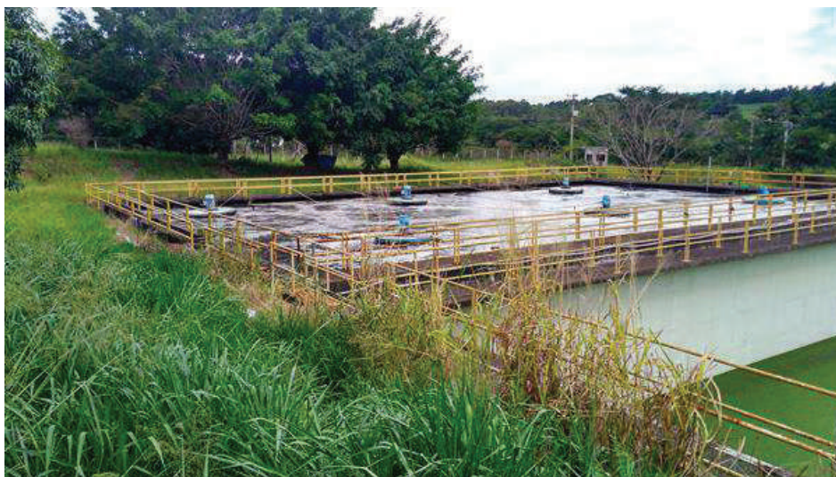
Figura 139 - ETE Jardim Luiza - Tanque de aeração 1.
