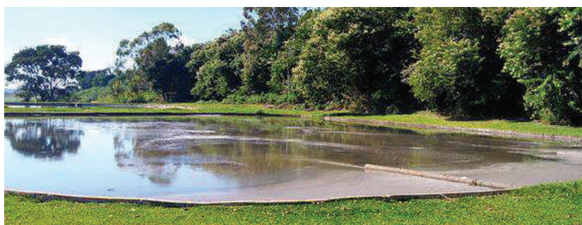
Figura 165 - ETE Paulistano II - Detalhe da Lagoa Anaeróbica.
