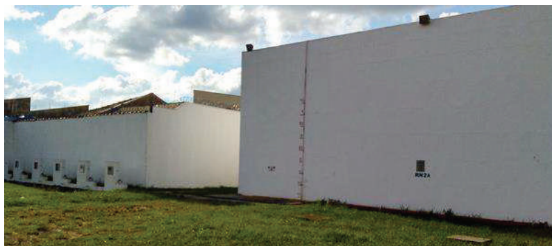
Figura 62 - Sistema Azevedo (SAz) (Setor II) - Reservatórios Padre Conrado - RN2A.
