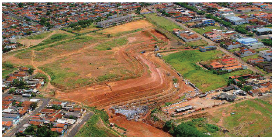
Figura 191 – Vista geral – Aterro das Maritacas.
