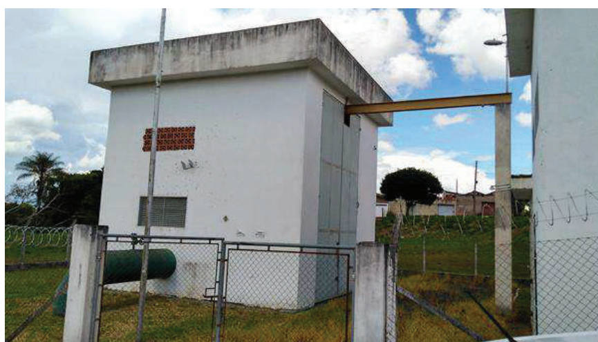
Figura 36 - Booster 2 "Dom Pedro" (entre o EC2 e a ETA) - Vista geral.
