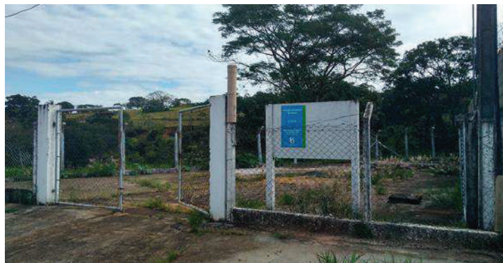
Figura 132 - ETE Jardim Luiza - Vista geral.
