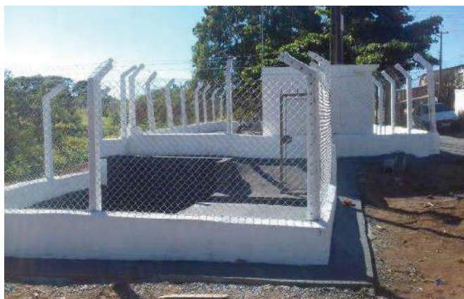
Figura 112 - EEE Palmeiras – Vista geral.
