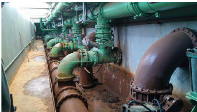
Figura 52 - ETA - Sistema de Lavagem dos Filtros.
