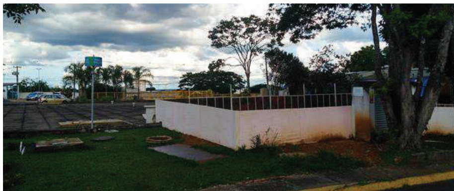
Figura 65 - Reservatório Enterrado RN3 – Vista geral.
