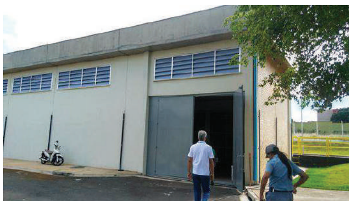
Figura 106 - Complexo de Integração dos Sistemas Norte e Sul - R5A - Vista geral do R5A.
