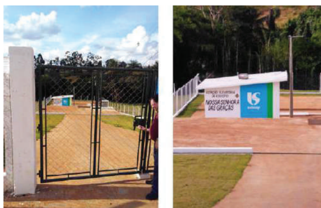
Figura 133 - ETE Nossa Senhora das Graças - Vista geral.
