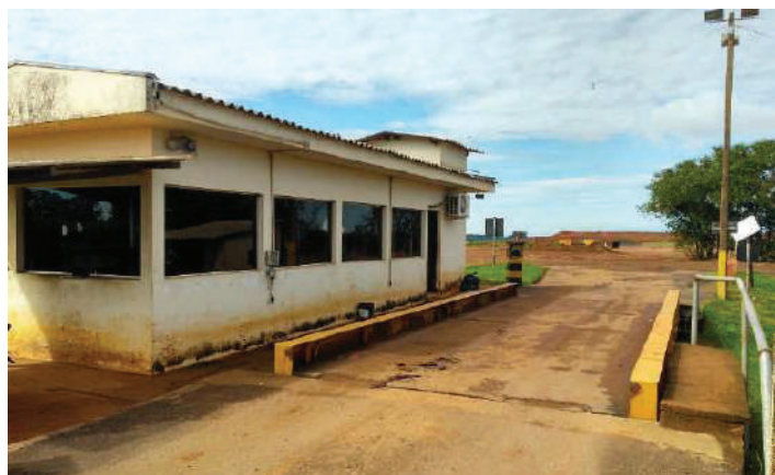
Figura 182 – Entrada e balança do Aterro municipal.
