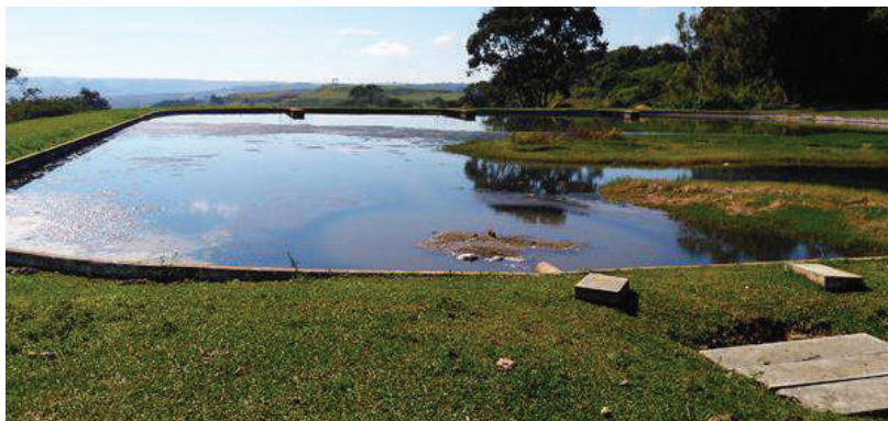
Figura 166 - ETE Paulistano II - 1ª lagoa facultativa – detalhe na alta densidade de vegetação na lagoa.
